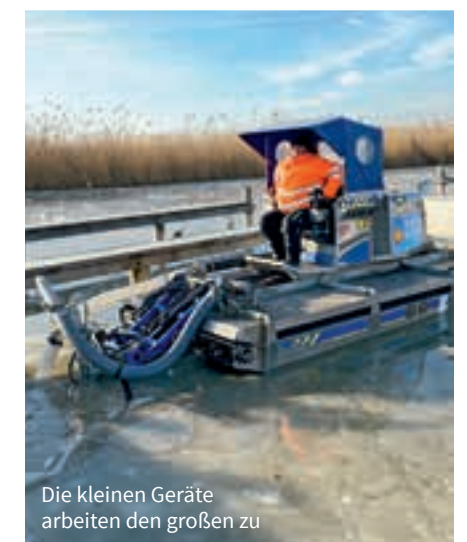
Nationalpark – Illmitz: Die Seearbeiten werden von Oktober bis April durchgeführt
