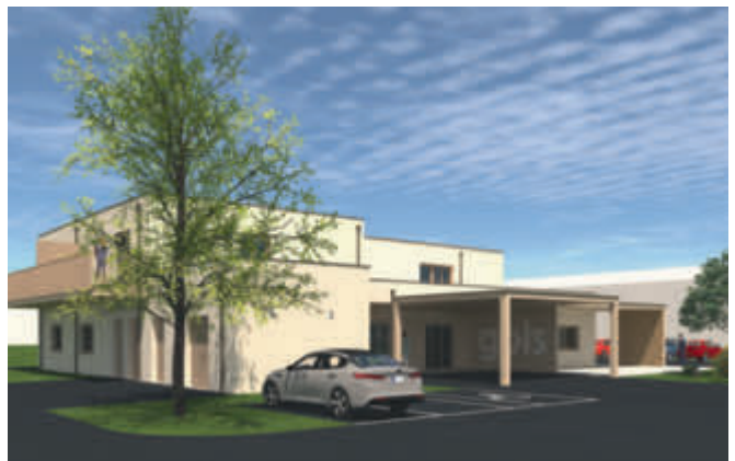
Der Spatenstich des Pflegestützpunktes Gols erfolgte im Dezember 2024
