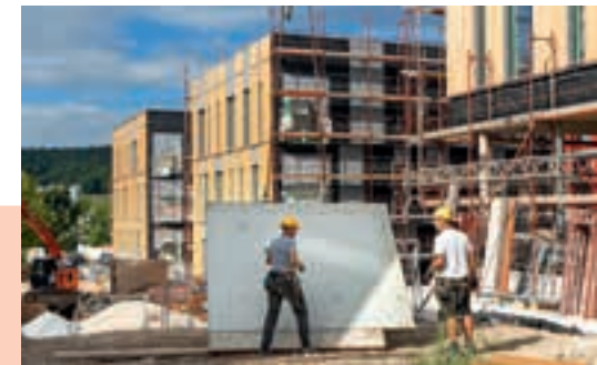
Aktuell sind rund 100 Fachkräfte auf der Baustelle im Einsatz
