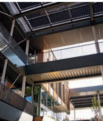
Die PV-Module beschatten den Innenhof und liefern gleichzeitig den Strom für Heizung, Kühlung und Lüftung
